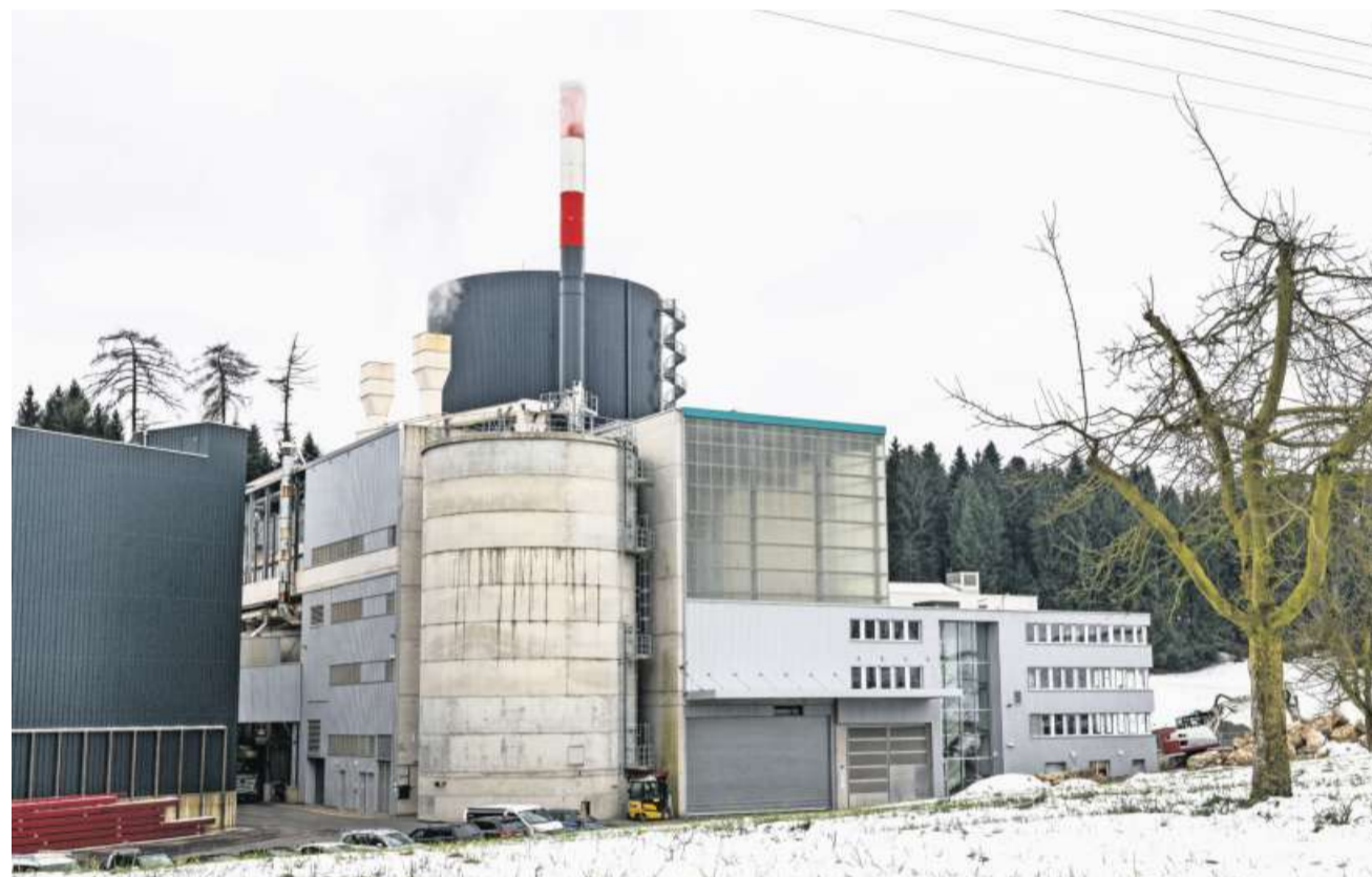
Bald schon soll die Region Arth-Goldau Fernwärme aus Haltikon bekommen.
